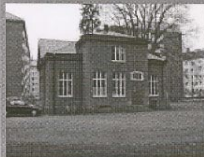
Bild från Granskolan, uppförd under slutet av 1800-talet, med den höga almen skymtandes bakom.
